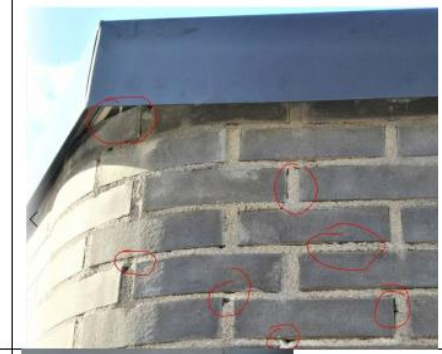
Tiiliverhouksen saumat hyvin vaihte
