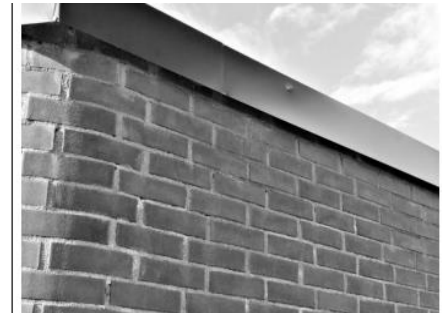
Kuva 8. Pystysaumassa kiviainestartunnoissa on paikoin huokasia. PPL
